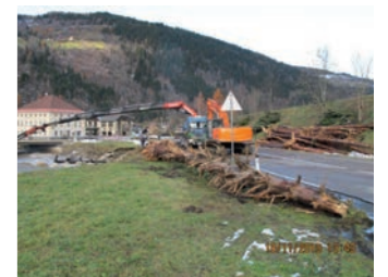
Foto 12: Räumungsarbeiten an der Turrach in Predlitz
