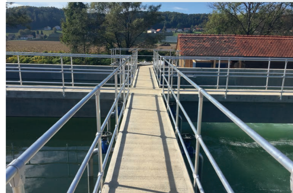
Foto 5: Steg über die neuen SBR-Becken
