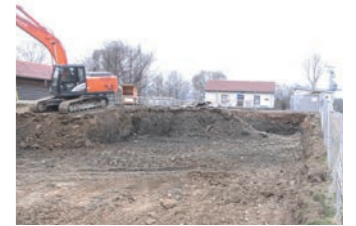
Foto 1: Aushub der Baugrube
