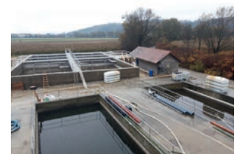
Foto 4: Kurz vor der Fertigstellung der neuen SBR-Becken
