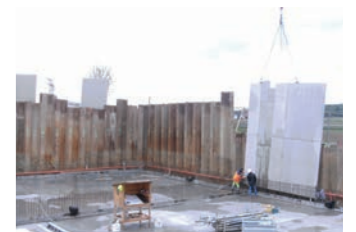
Foto 3: Beginn der Schalungs- und Betonierarbeiten
