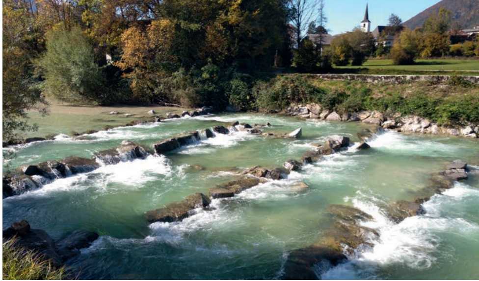
Foto 6: Aufgelöste Rampe an der Ager bei Vöcklabruck als naturnahe, für Fische und andere Organismen passierbare Alternative zum ursprünglich nicht passierbaren Absturzbauwerk
