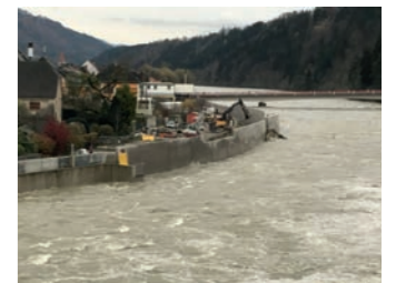
Foto 11: Baustelle Hochwasserschutz Lavamünd
