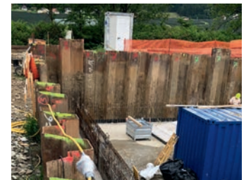
Foto 2: Umspundung der Baugrube
